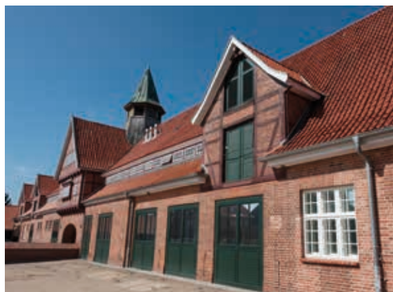
Das Karree während der Sanierung, 2015
